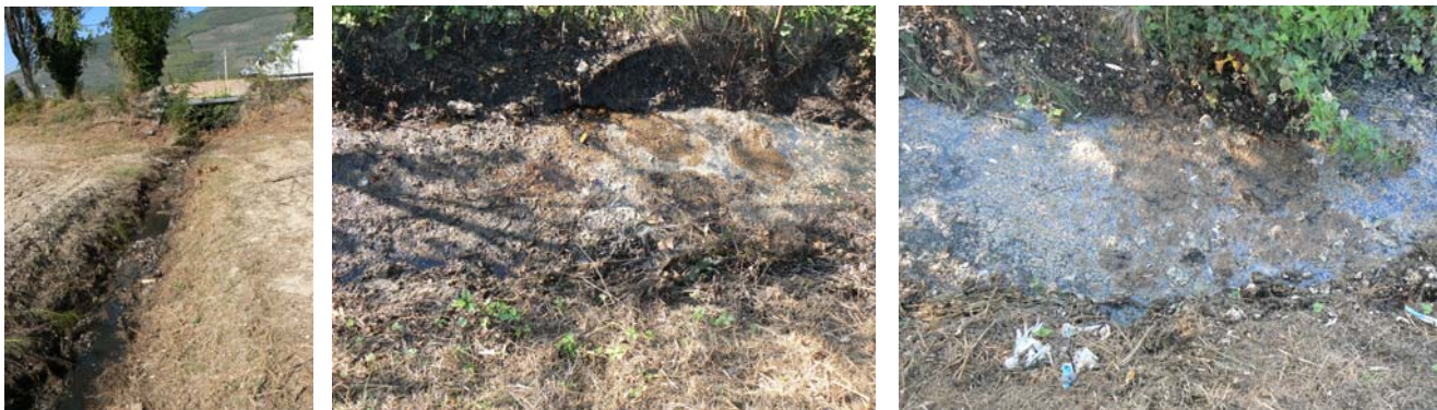
Fig. 6.1.2 – Stato dell’affluente Fossa Nuova nel tratto iniziale, localizzato nella zona industriale di Campello sul Clitunno .
