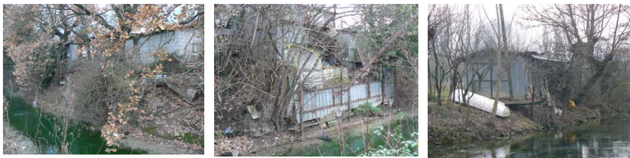
Fig. 6.1 – Esempi di strutture realizzate a ridosso del fiume Clitunno .
